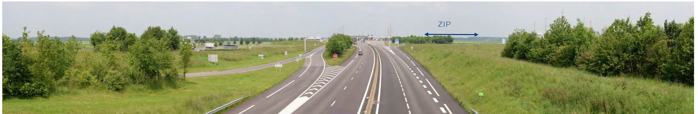
Photographie 16 : vue depuis les abords du péage de l'A29
