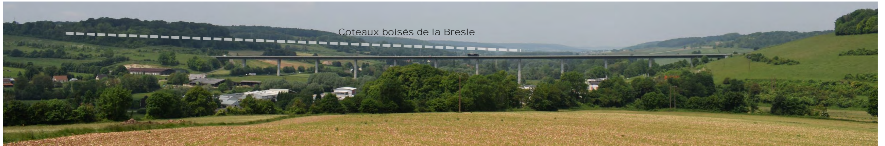
Photographie 23 : La vallée de la Bresle franchie par le viaduc de l'A 29
