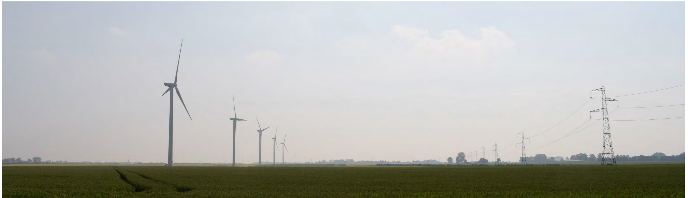
Photographie 72 : Les éoliennes parallèles à la ligne haute tension.
