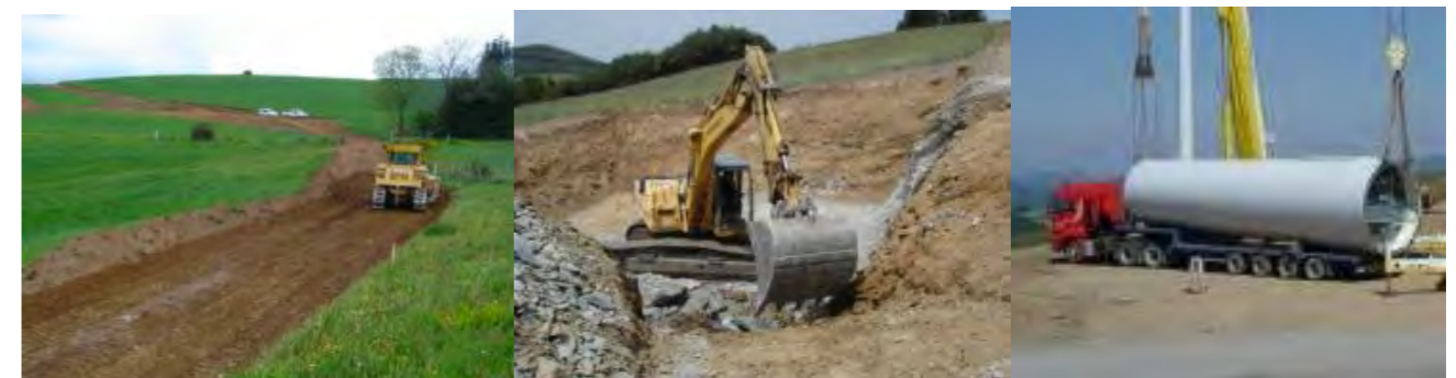
Photographie 77 : illustration d'un chantier éolien
