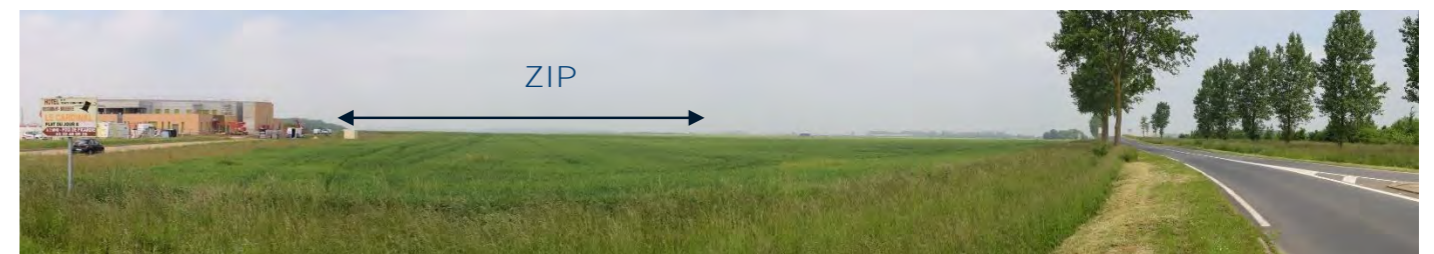
Photographie 41 : La RD 901 à l'aire du Croixrault.
